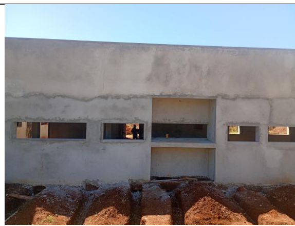
Revestimento Parede - fevereiro/2026
