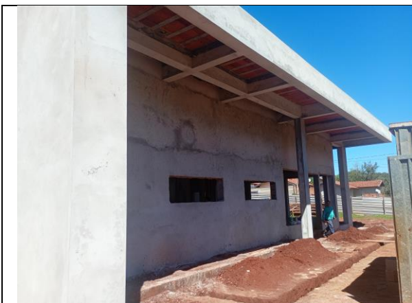
Revestimento Parede - fevereiro/2026
