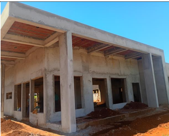
Revestimento Parede - fevereiro/2026
