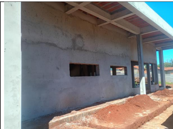
Revestimento Parede - fevereiro/2026
