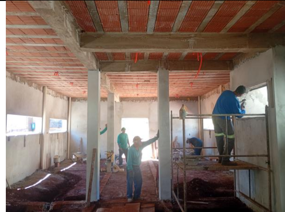
Revestimento Parede - fevereiro/2026
