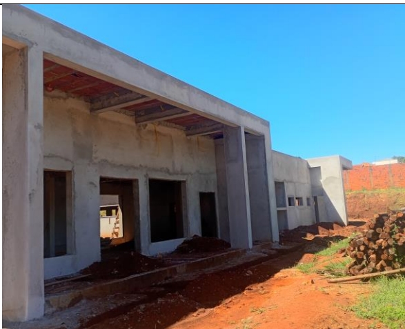
Revestimento Parede - fevereiro/2026
