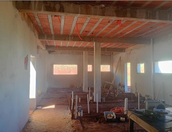
Revestimento Parede - fevereiro/2026
