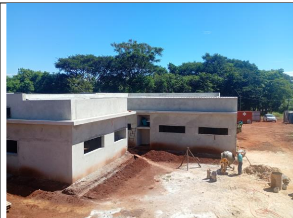
Revestimento Parede - fevereiro/2026
