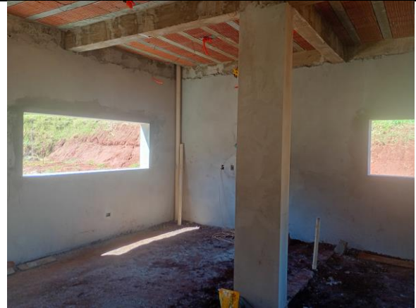
Revestimento Parede - fevereiro/2026
