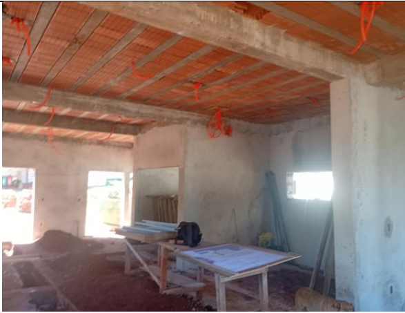
Revestimento Parede - fevereiro/2026
