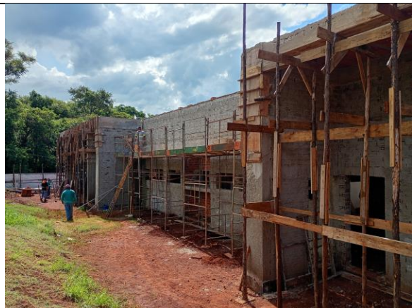
Chapisco e Concretagem da Armação - janeiro/2026
