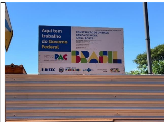
Placa da Obra – janeiro/2026
