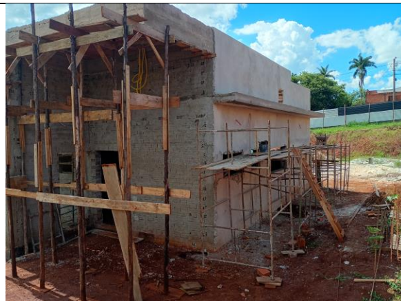
Chapisco e Concretagem da Armação - janeiro/2026
