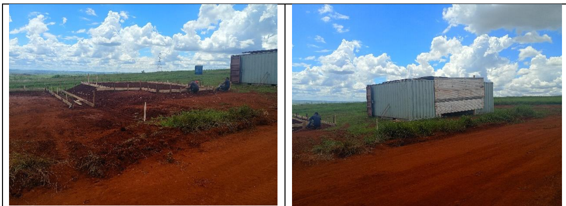
CANTEIRO DE OBRA
