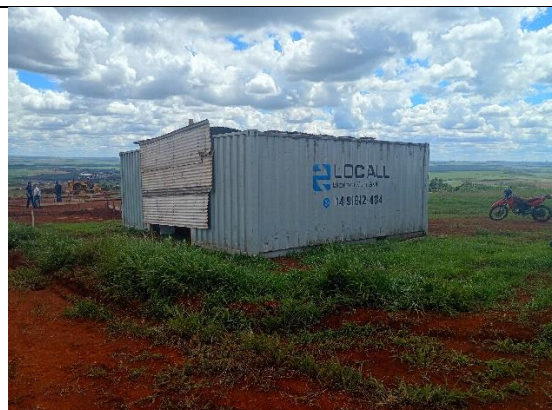
CANTEIRO DE OBRA
