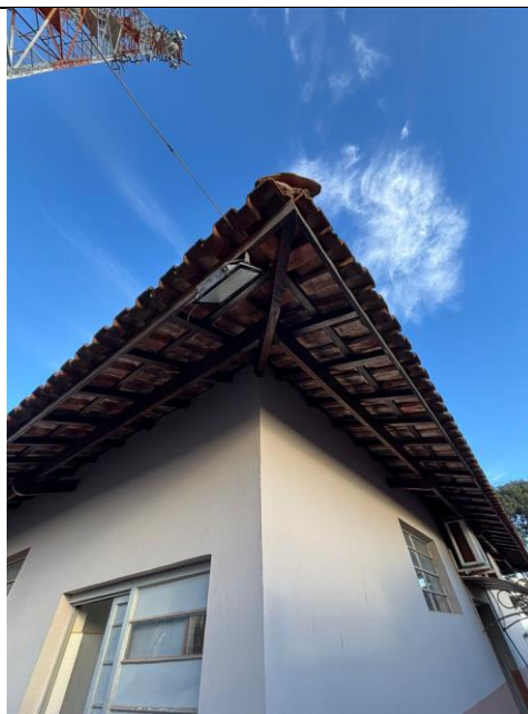
Pintura da Estrutura de Madeira Telhado
