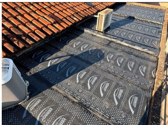
Impermeabilização da Laje da Varanda
