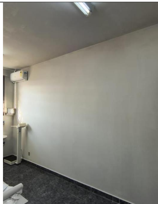
Pintura das Salas
