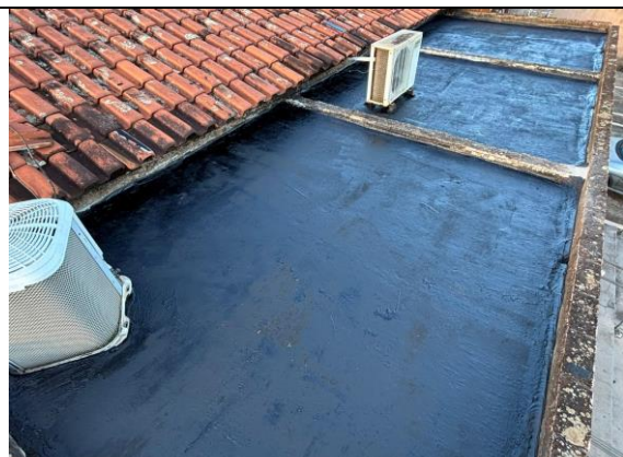
Impermeabilização da Laje da Varanda
