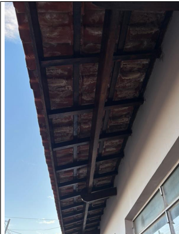
Pintura da Estrutura de Madeira Telhado
