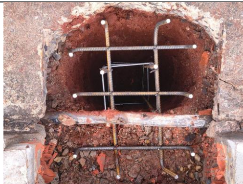
Armação da Sapata da Cobertura
