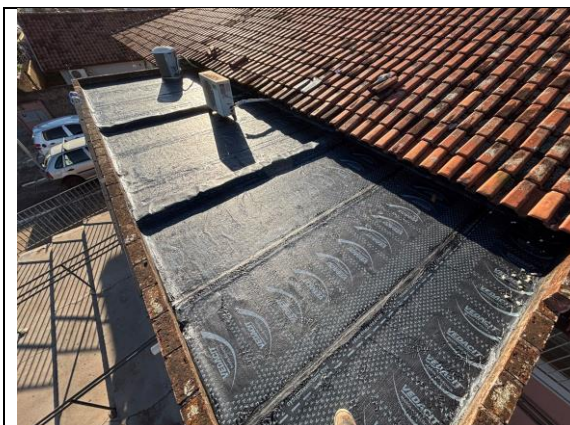
Impermeabilização da Laje da Varanda
