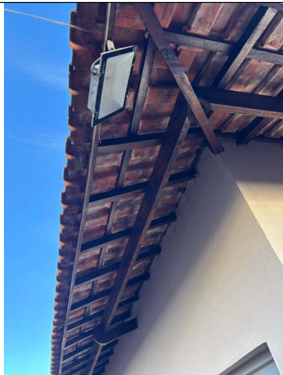
Pintura da Estrutura de Madeira Telhado
