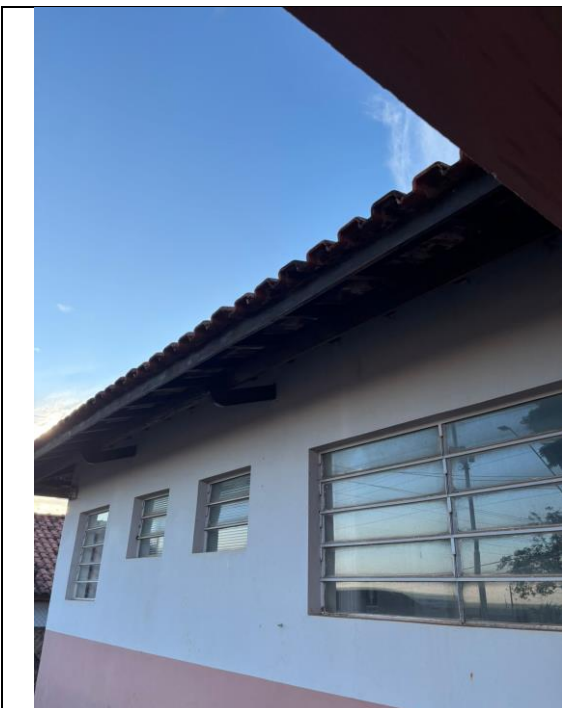
Pintura da Estrutura de Madeira Telhado
